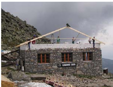
Svojpomocná nadstavba podkrovia a osadenie prvej kroky novej strechy, 2006.
